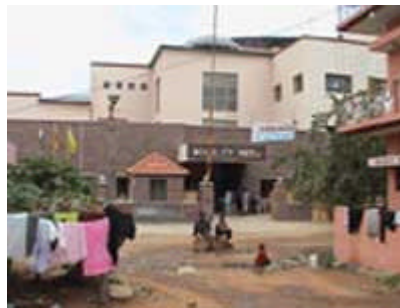
Le bâtiment "Centre du Handicap"
